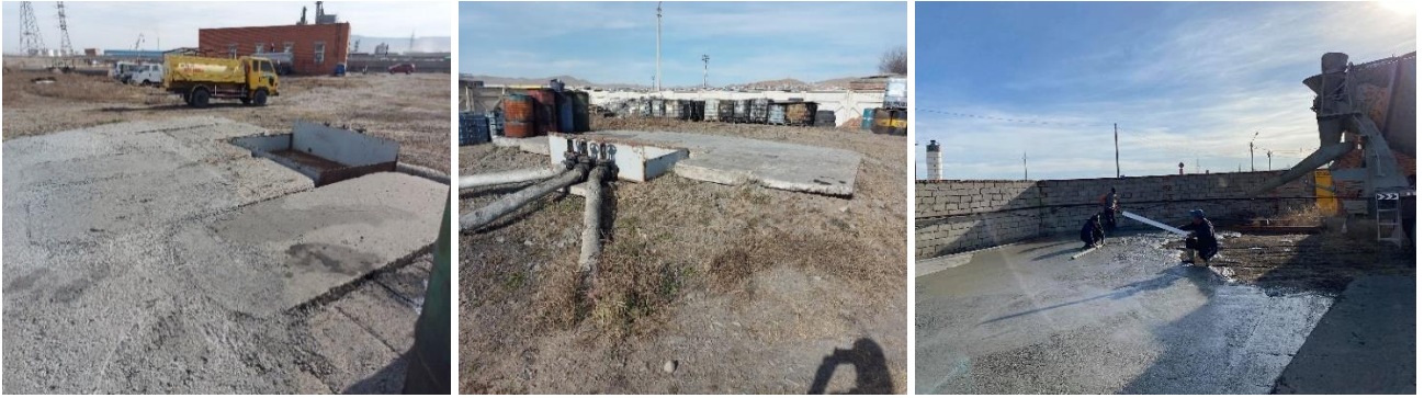
Зураг 17. Бетоны ажил
